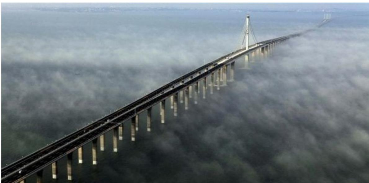
Рисунок 1 - Ціндаоський міст через затоку Цзяочжоу (КНР), довжина 42,5 км, 5200 залізобетонних опор
