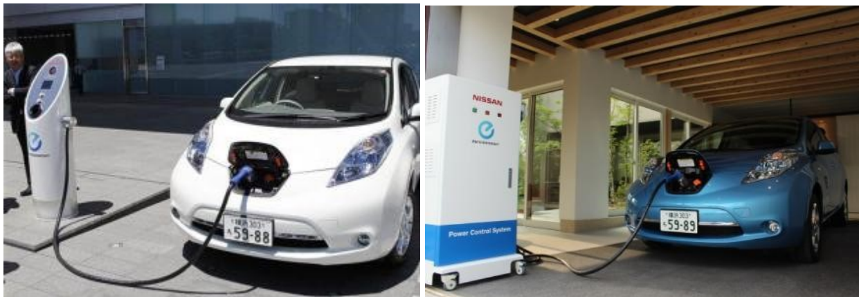
Рисунок 3 – Зарядні станції для електромобілів
