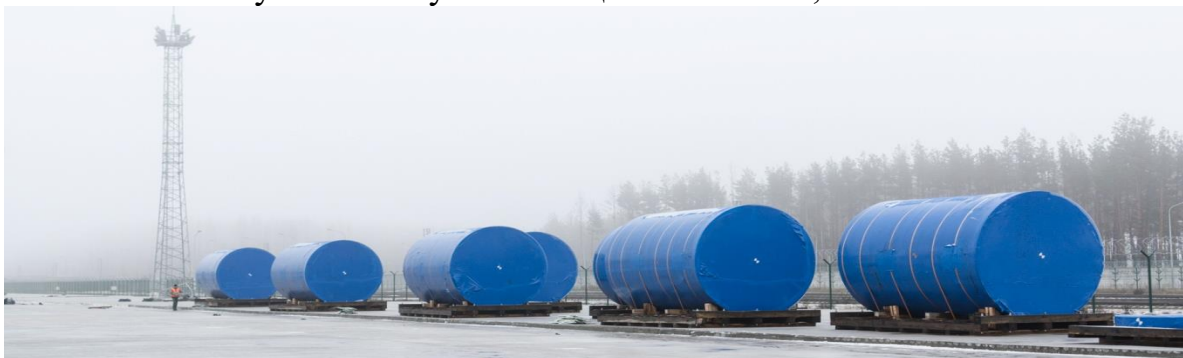
Рисунок 4 – Сухе сховище ЦСВЯП, пресцентр НАЕК “Енергоатом” 2020
