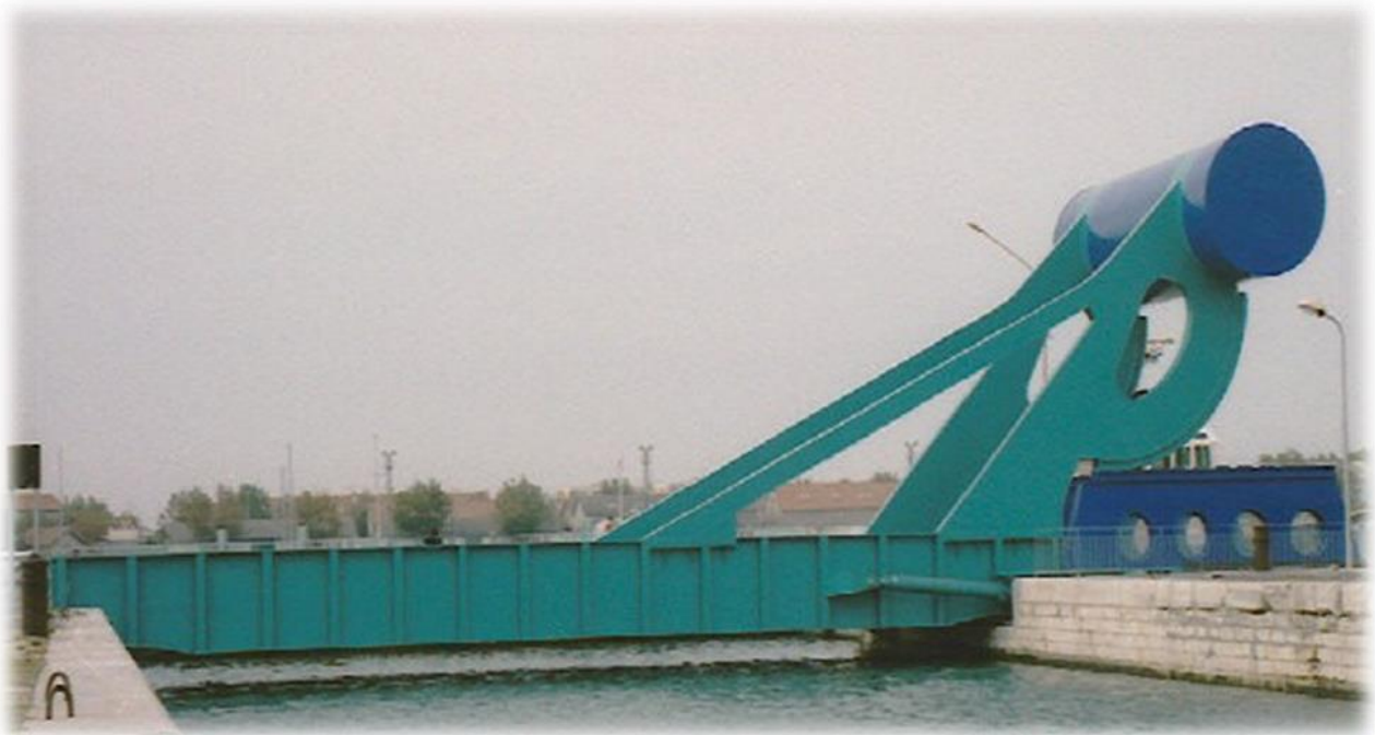
Рис. 2. Міст з противагою
