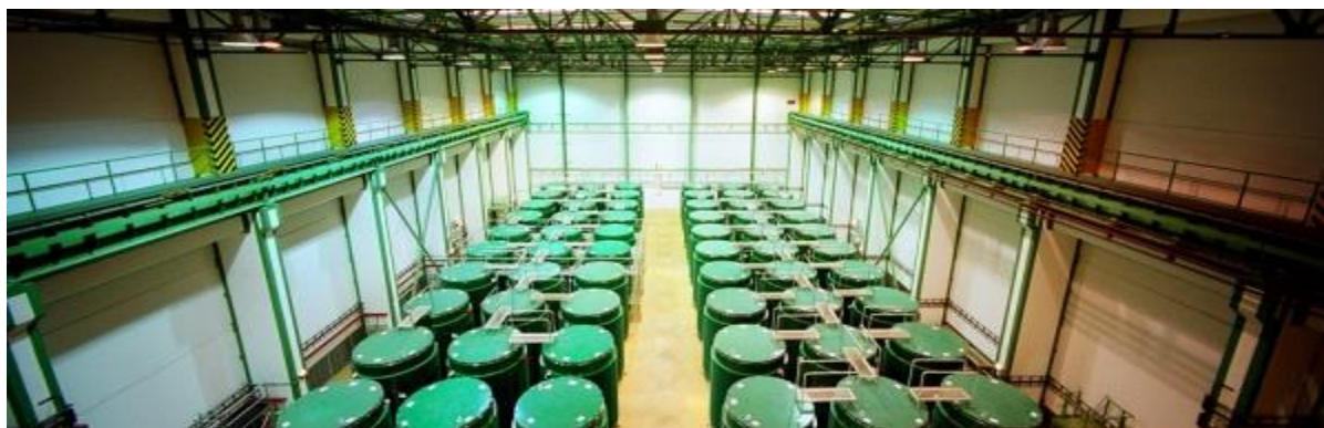
Рисунок 2 – Сухе сховище ВЯП АЕС «Дуковани» (Чехія)
